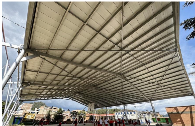
Cubierta_Colegio Santo Tomas
