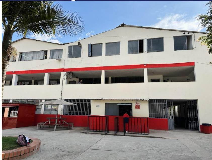
Nueva fachada_Colegio Santo Tomas
