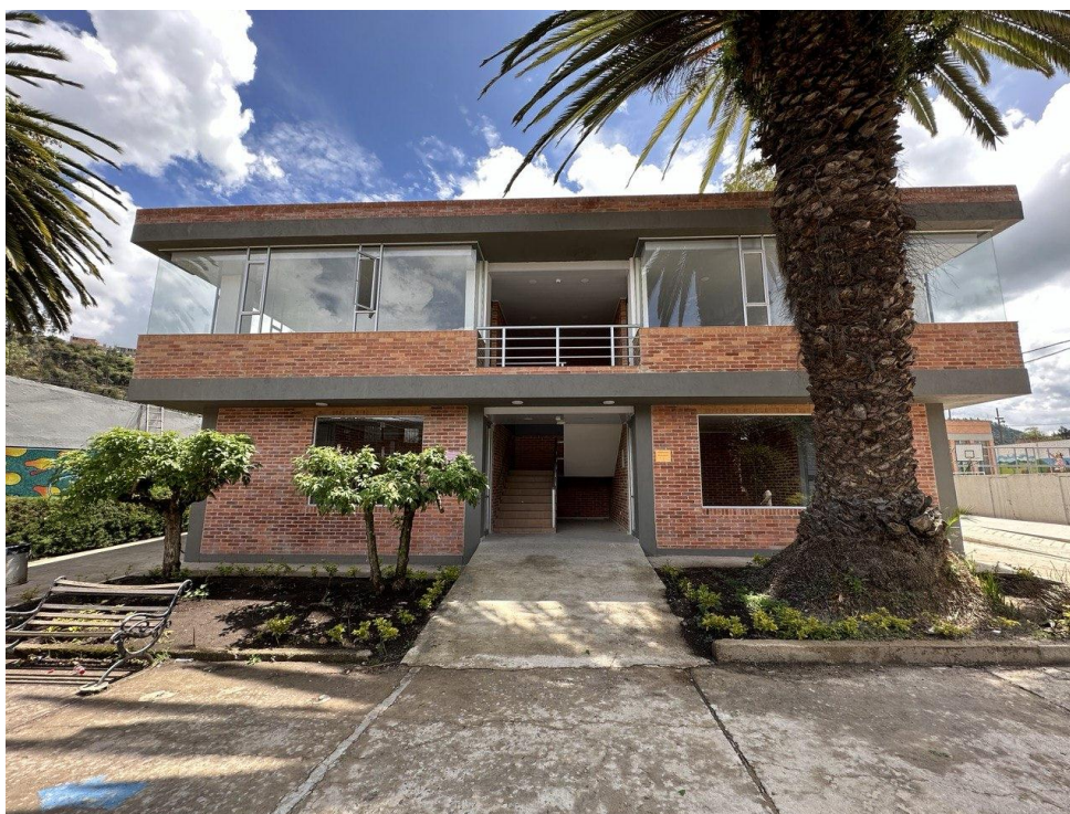
Edificio administrativo_ Colegio Rafael Reyes
